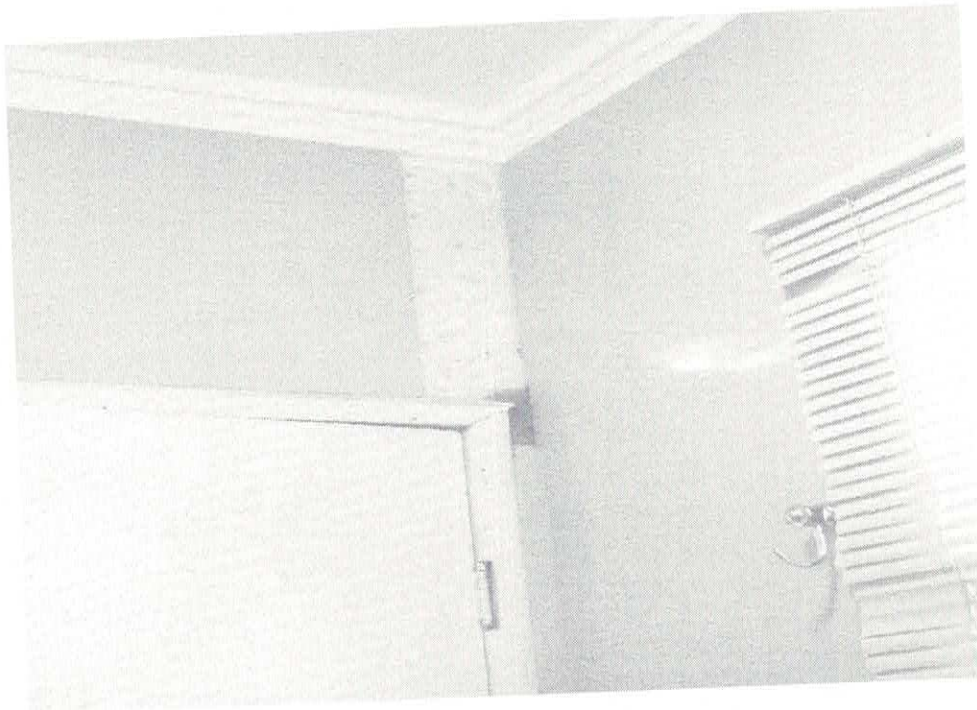
Foto 04. Falta de revestimento na parede do banheiro do gabinete do presidente.
